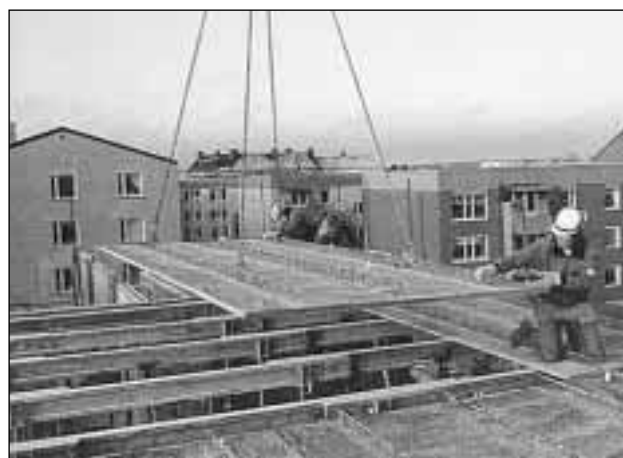
Figur 5. Plattendekke heises på plass.
